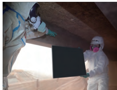
橋梁補修工事施工管理支援事例
