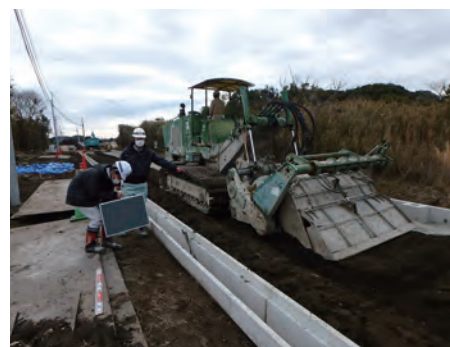
道路改良工事施工管理支援事例
