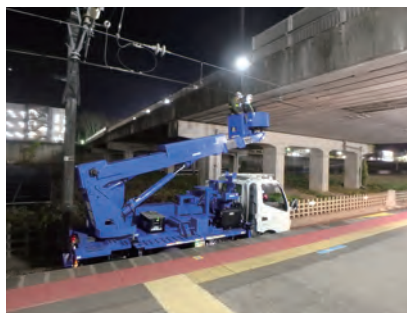
橋梁定期点検業務
