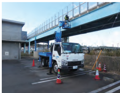
橋梁定期点検業務
