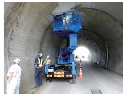
トンネル定期点検業務
